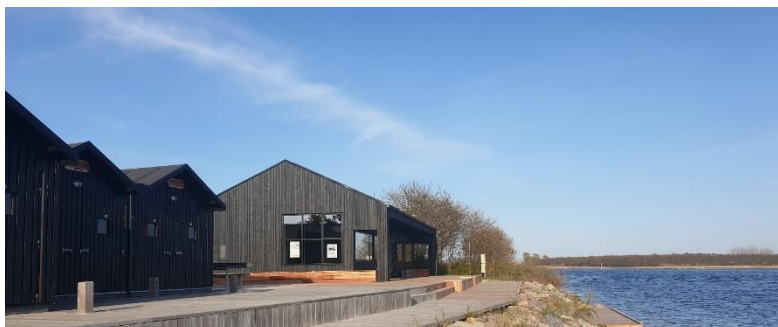
Klintebjergs fjordhuse, fælleshuset Skalleværket og tilhørende promenade tager sig godt ud i al slags vejr. Etableringen blev støttet af LAG MANK i programperioden 2014-2022, og er et godt eksempel på borgerdreven landsbyudvikling.
